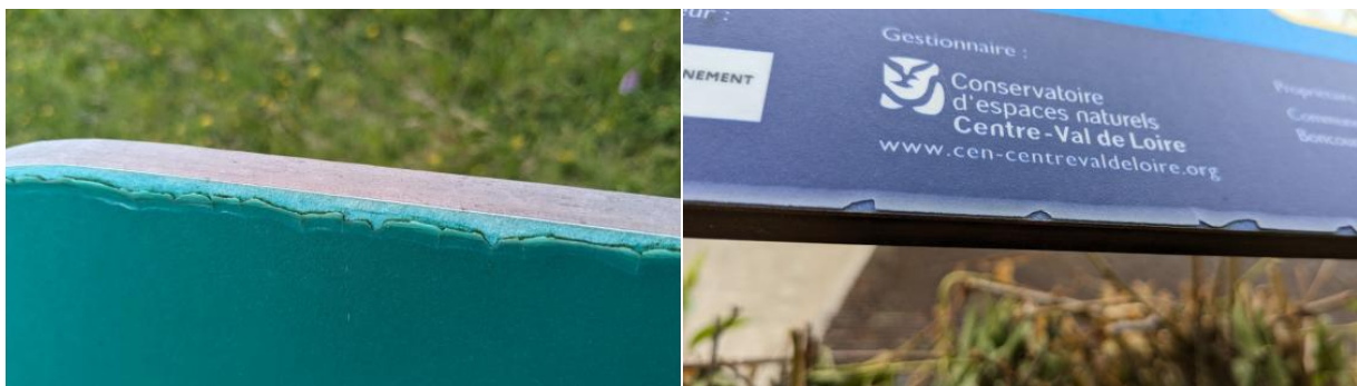
Défauts de conception constatés sur les panneaux pédagogiques (Photos : Cen CVL/S. Garbar)
