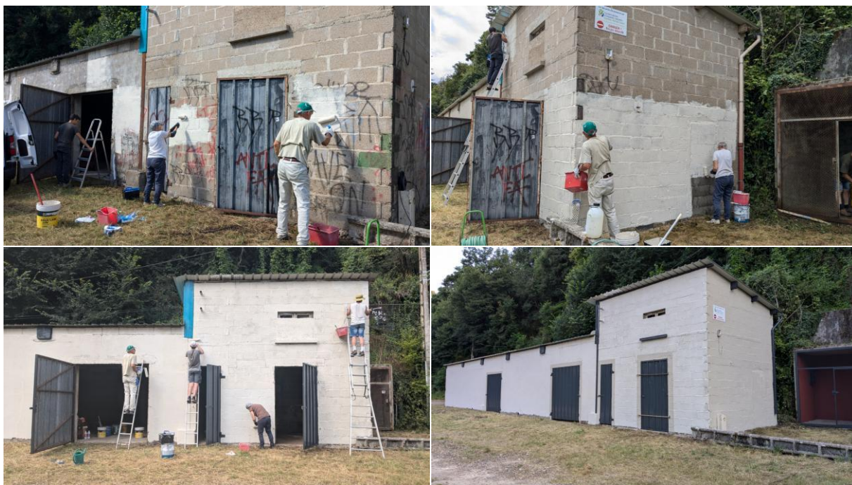
Chantier de ravalement en juillet (Photos : Cen CVL/S. Garbar)
