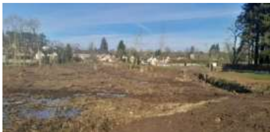
Fin de chantier avant remise en état (parcelle 952) - 12 décembre
