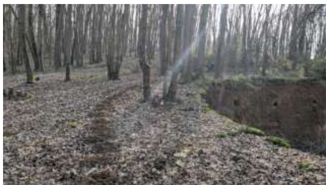
Creusement des trous pour la plantation de haie (Photos : Cen CVL/S. Garbar)
