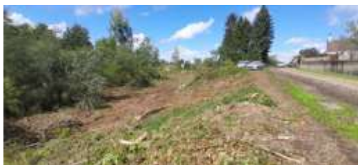
1 ère phase du chantier (rue des laitiers) - 02 septembre 2025
