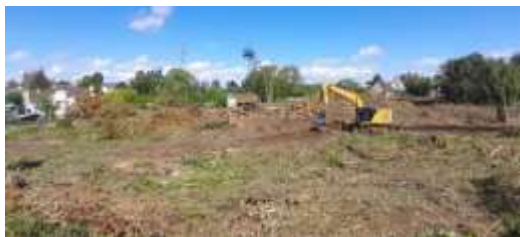
2 ème phase du chantier (parcelle 869 Nord) - 12 septembre 2025
