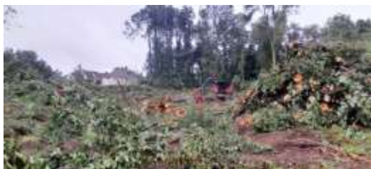
1 ère phase du chantier (parcelle 869 Nord) - 02 septembre 2025
