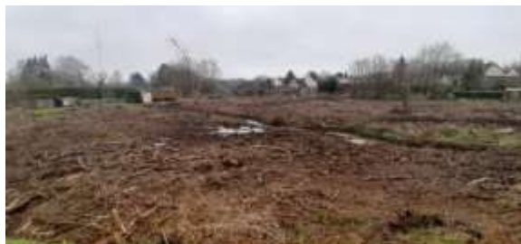
Fin de chantier avant remise en état (parcelle 869 Nord) - 12 décembre 2025
