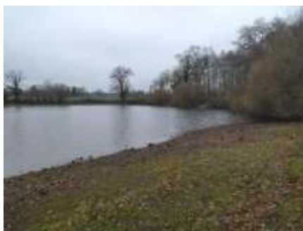
Niveau d'eau bas au 12 décembre 2025
